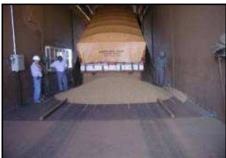
Dopo l'installazione del controllo delle polveri
